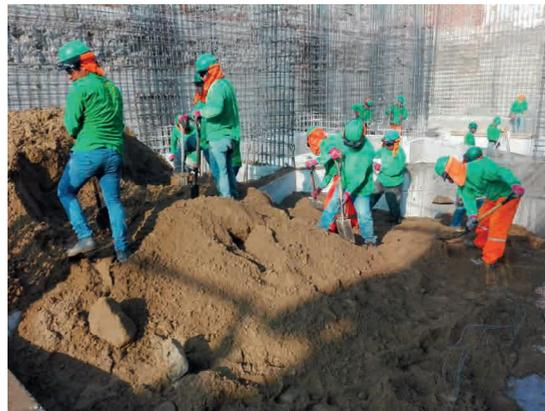
*Obreros haciendo trabajo de relleno en el terreno destinado para la CMAC Piura-Trujillo.*
